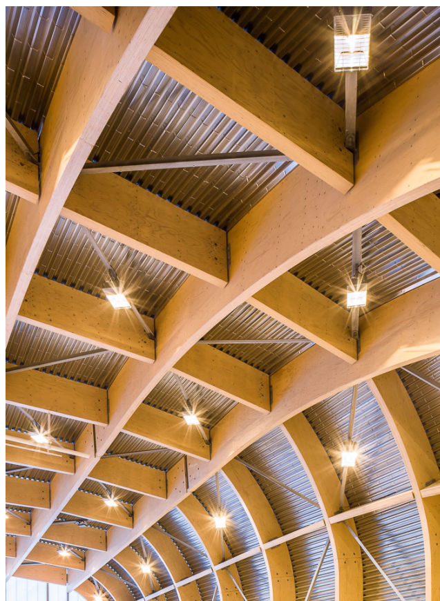
Kuva 3. Kerrannaisliimattuja ja kaarevaksi työstettyjä palkkeja urheiluhallin kattorakenteessa.
